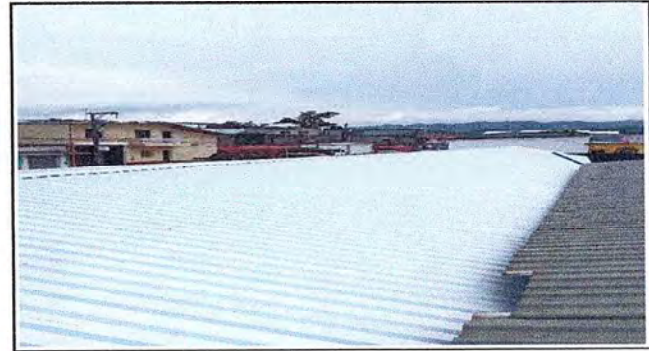
Foto 4: Cambio de techo
