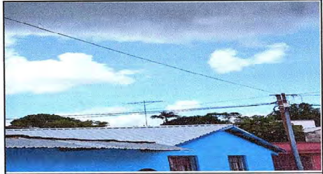
Foto 2: Reforzamiento de costaneras laterales.
