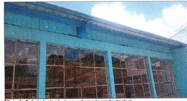
Foto 6: Cubrimiento de área externa (pared y techo).
