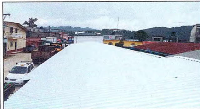
Foto 3: Cambio de techo
