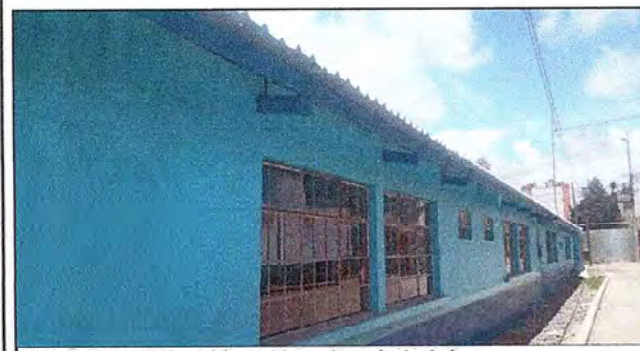
Foto 5: cubrimiento del área externa (pared y techo).
