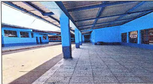
Foto1: Cambio de costaneras
